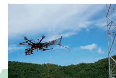
ドローン延線 Extension Work Using a Drone
