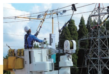
アシストアームによる間接活線作業 Indirect Live-Line Work Using an Assist Arm
