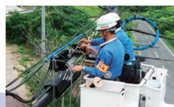
光ファイバー接続工事 Fiber Optic Connection Construction
