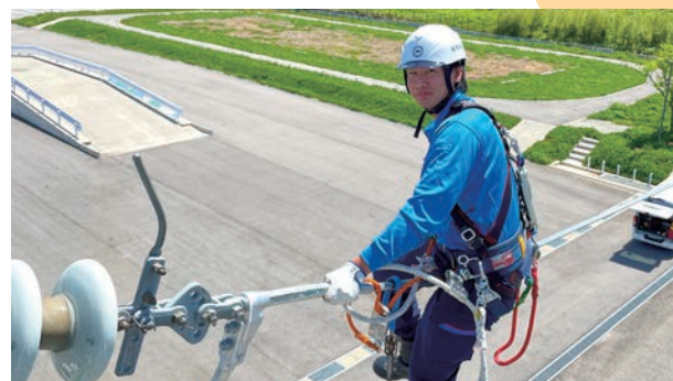
電線宙乗り訓練 Aerial Power Line Work Training
